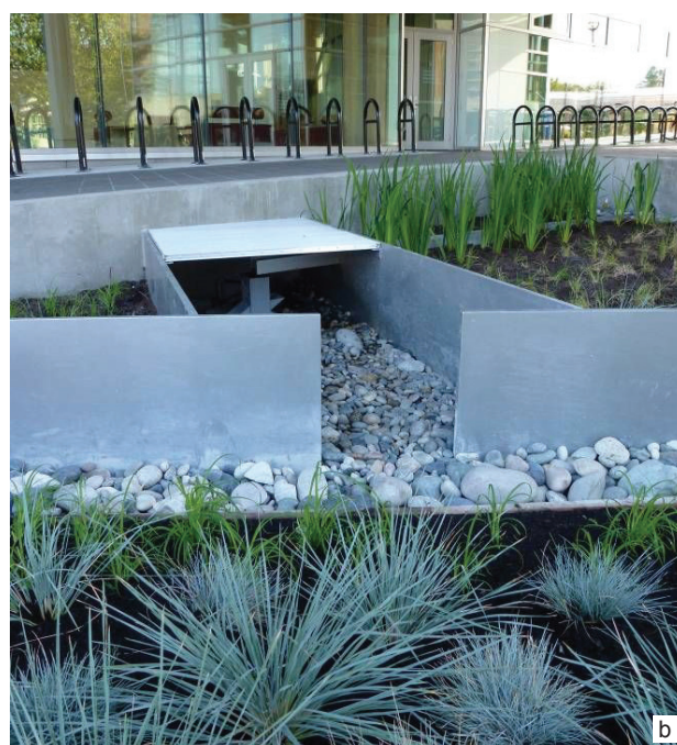
Il. 10. Elementy zieleni na działce: a) zielony dach nad salą wykładową w atrium porośnięty roślinnością lokalną i odporną na suszę, b) ogród deszczowy z roślinnością dobrze znoszącą okresowo stojącą wodę
