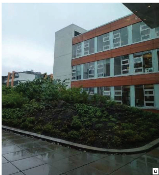
Il. 10. Elementy zieleni na działce: a) zielony dach nad salą wykładową w atrium porośnięty roślinnością lokalną i odporną na suszę, b) ogród deszczowy z roślinnością dobrze znoszącą okresowo stojącą wodę
