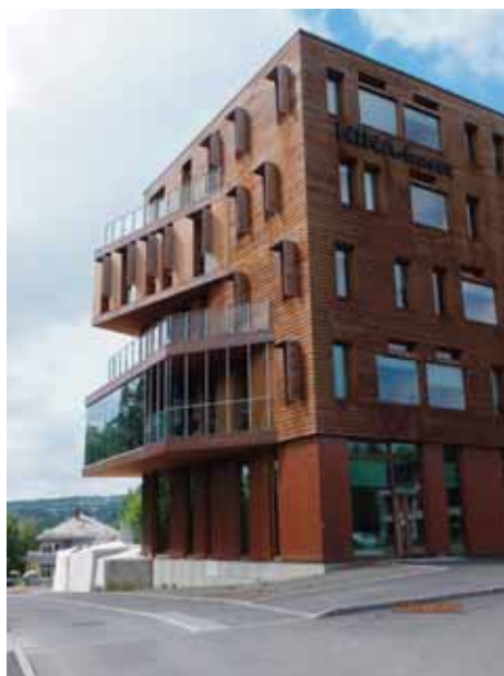
Rys. 5. Budynek NINA – fasada szczytowa od strony podmiejskiej linii kolejowej [aut.]
