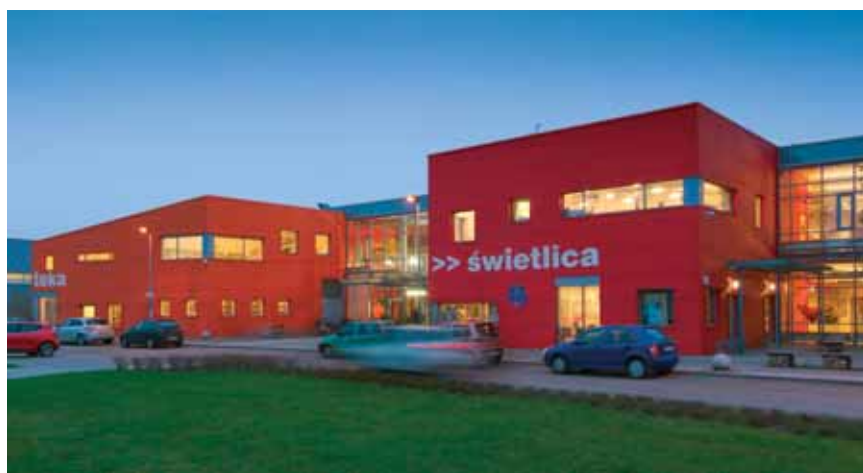
Il. 3. Widok wejścia od strony ulicy Suwalskiej, strefa publiczna
