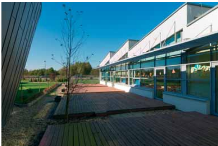
II. 1. Widok części przedszkolnej z osłonami przeciwsłonecznymi, dachem szedowym i tarasami
