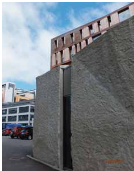
Rys. 6. Budynek NINA – fragment „podium” fasada szczytowa od strony podmiejskiej linii kolejowej [aut.]
